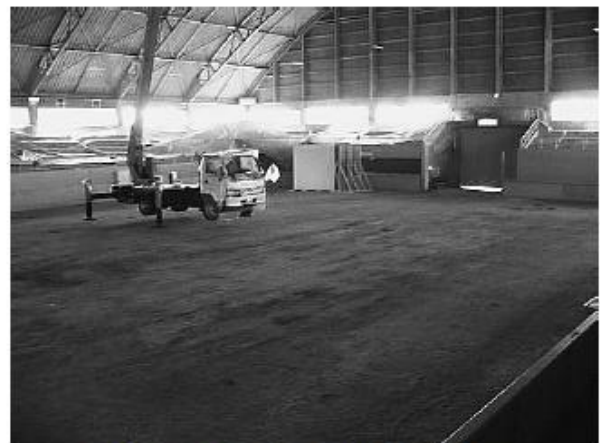
準備が進む共進会場(塗装工事中)
