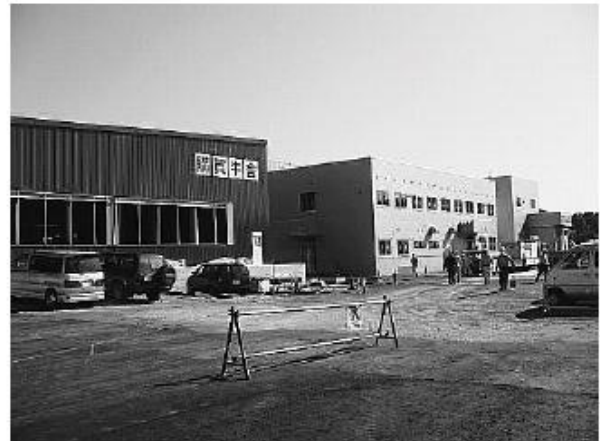
建設中の家畜市場 (左:購買牛舎、右:セリ場、事務所)
