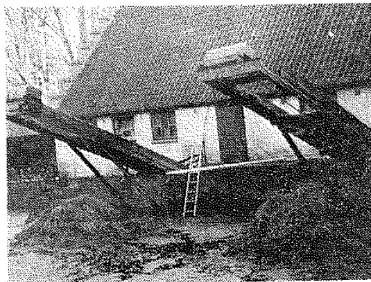
農家豚舎の排糞装置(電気によりチェーンで豚舎内の排糞を舎外へ運搬する)
