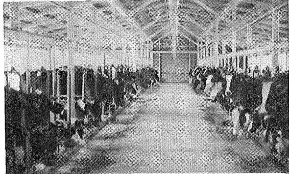
特別診断指導を受けて建てた牛舎内部 (岡山市東山内 K牧場)
