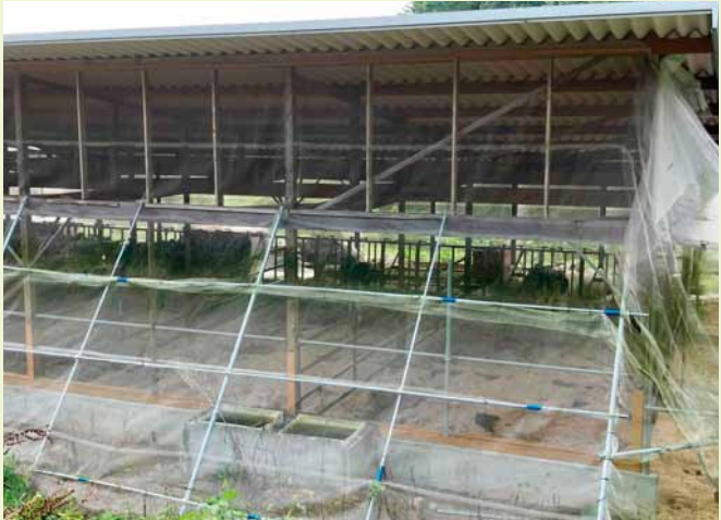
図2 防虫ネットの設置例 高梁大池山育成牧場
