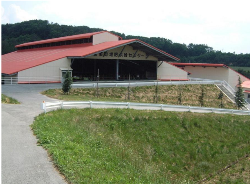
新見市哲多町堆肥供給センター
