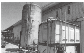
既存の飲水タンクを利用し、吊るして、ばっ気するだけ
