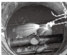
既存の飲水タンクを利用し、吊るして、ばっ気するだけ
