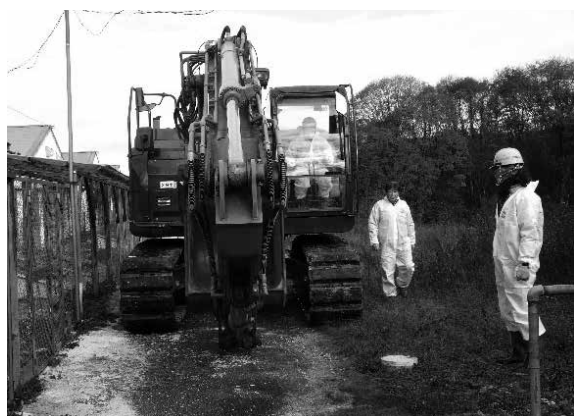
図5 掘削重機の移動の様子
