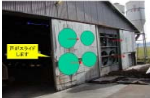
トンネル換気(外側)
