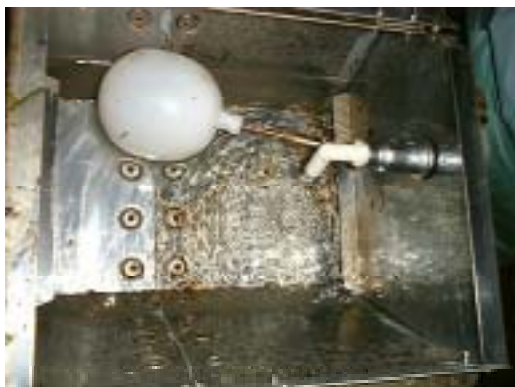
写真3 S牧場フロート式給水弁
